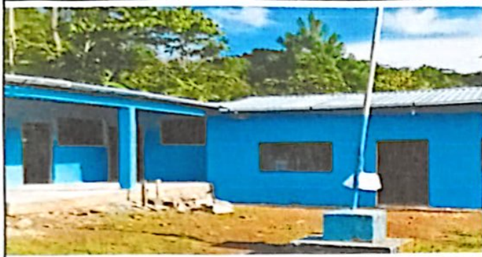
Foto 1: Reconstrucción de cocina Escolar.
