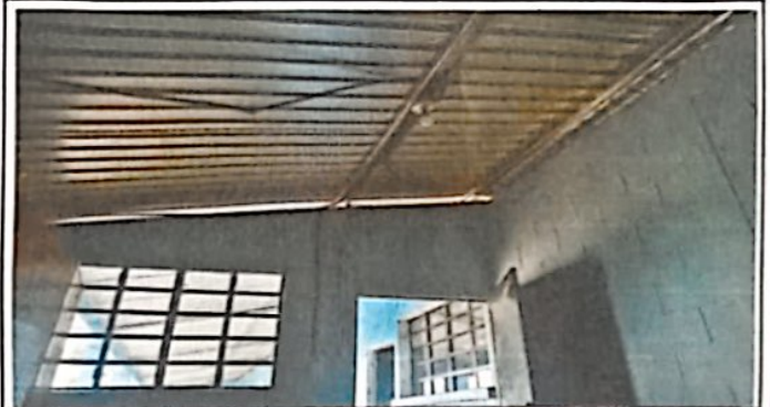
Foto 4: Instalación de sistema eléctrico en dos aulas, dirección y cocina
