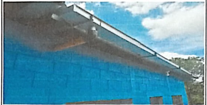
Foto 2 Colocación de canales y tubos para bajada del agua hacia los tinacos
